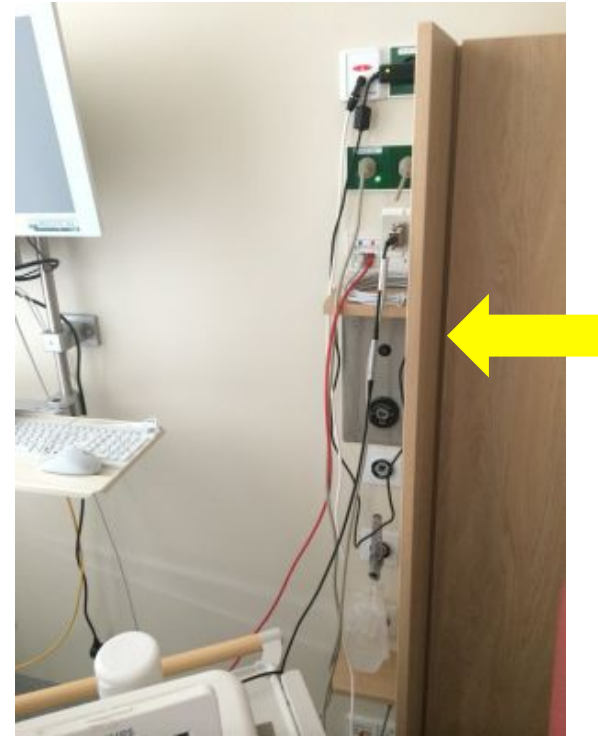
Træskinne på Olgahospital skjuler udstyr og tilslutninger fra brugerens synsvinkel
