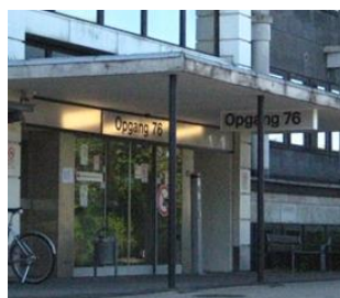
Section 7602: Ole Maaløes Vej 26, 2200 Copenhagen North
