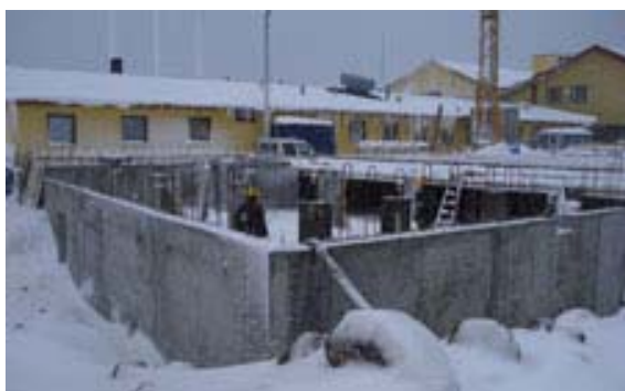
Byggeriet af den nye lægeklinik er stadig i fuld gang.
